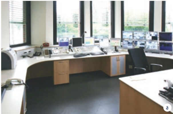
Kombination aus Pforte und Sicherheitsleitstand mit Videomonitoring.
