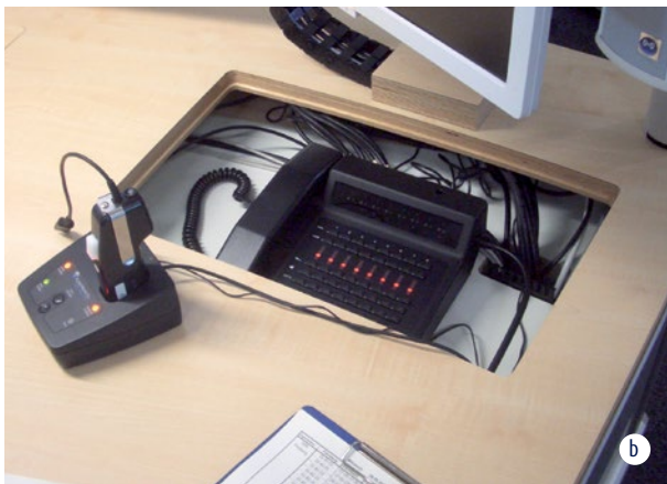
Zugriff in den Versorgungsraum unter der Arbeitsplatte
